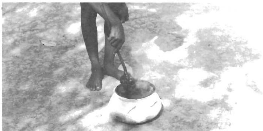
Figura 16 - Impermeabilização com resina de jutaí.
