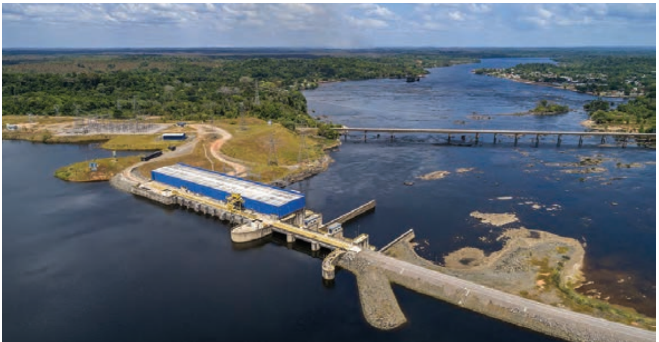
A Hidrelétrica Ferreira Gomes é a barragem mais a jusante do rio Araguari, situada logo a montante da ponte que liga a principal rodovia entre Macapá e a Guiana Francesa.
