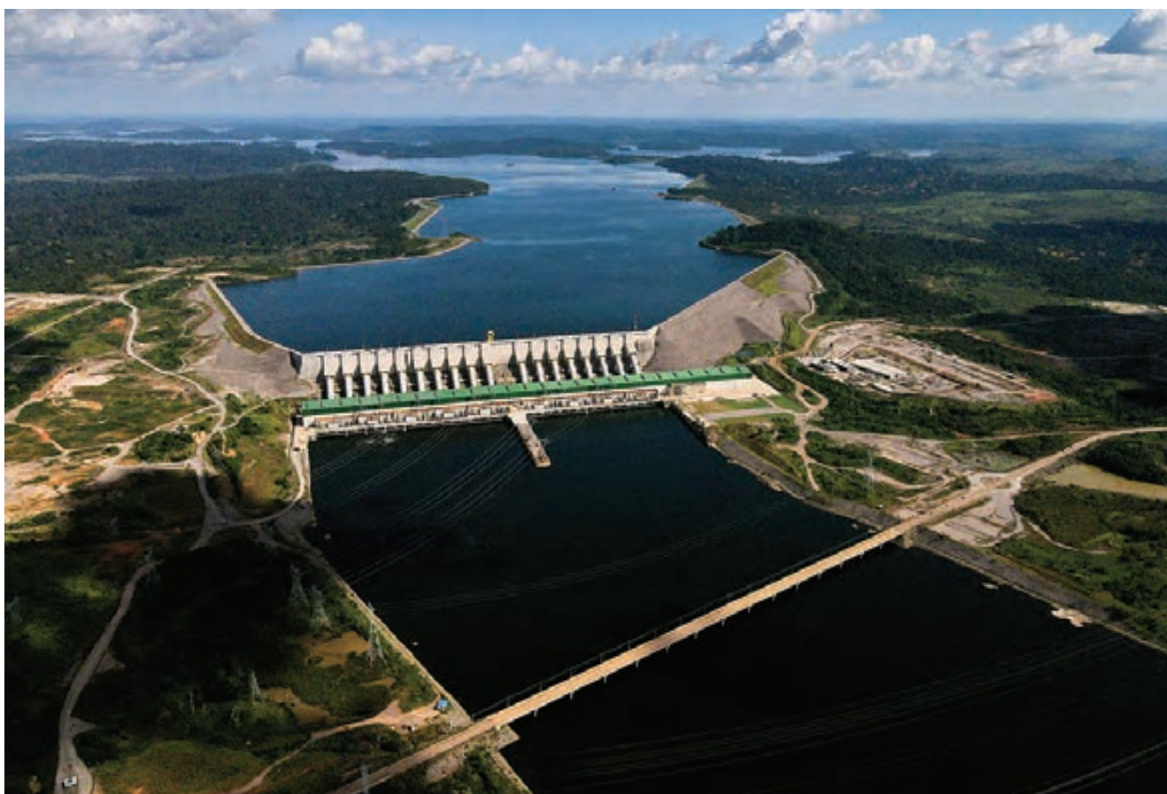
Hidrelétrica de Belo Monte no Baixo Xingu, próximo às corredeiras da Volta Grande do Xingu.
