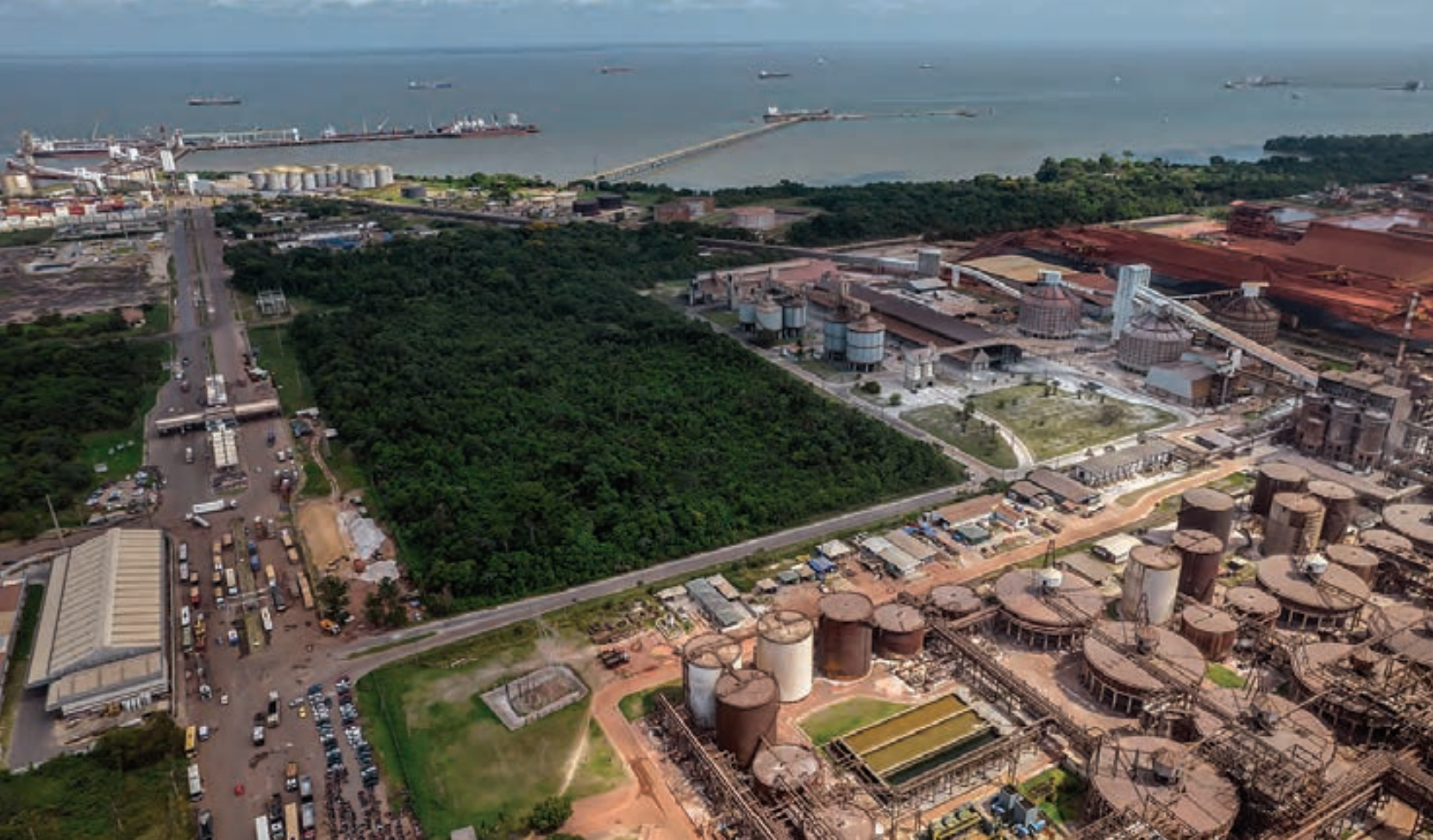
Usina de processamento de alumínio na orla do rio Pará, a montante de Belém.
