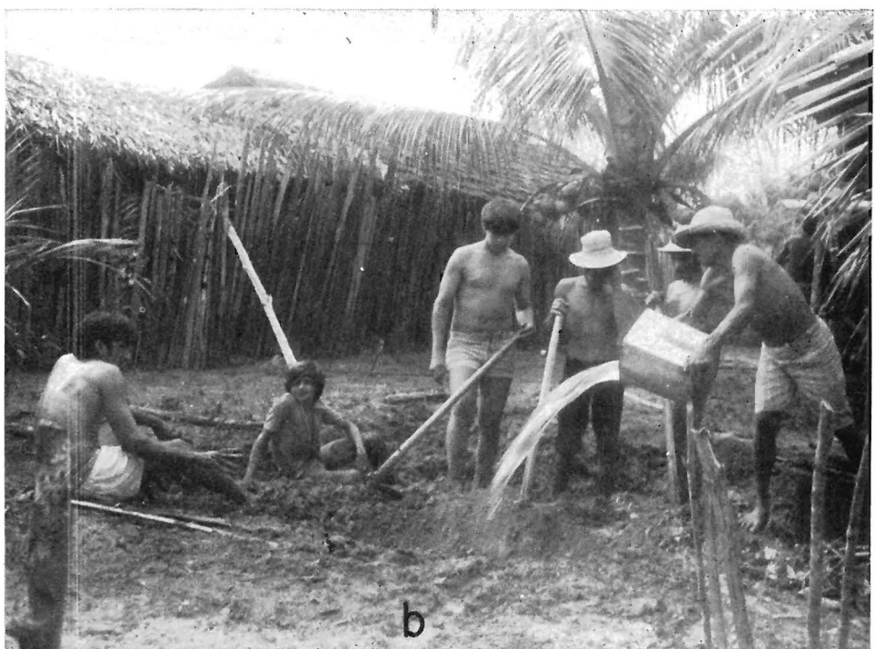
Est. IV : a) — Tipo de arado existente no Distrito de Quatipuru; b) — Mutirum para embarrear uma casa (Fotos de Maciel da Silveira, 1976).
