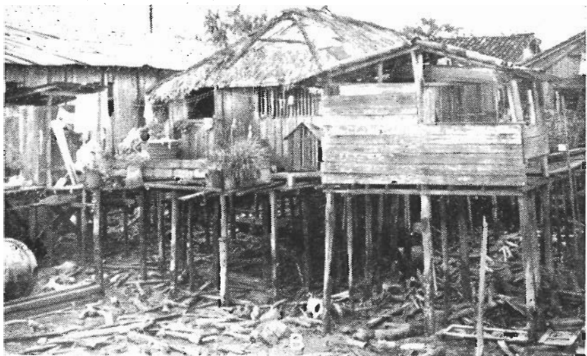
a — Aspecto geral das moradias do núcleo "Vila da Barca", predominando o tipo palafita. b — Detalhe das casas do núcleo "Vila da Barca", mais próximas da baía de Guajará.
