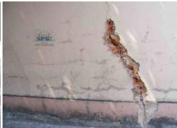
Fig. 54 - Rachadura no muro do PZB na Tv. Nove de Janeiro.
