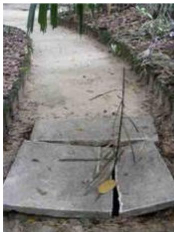
Fig. 05 - Risco aos visitantes no I Quadrante, com a tampa quebrada de uma galeria de águas pluviais no meio da trilha de visitaç o.
